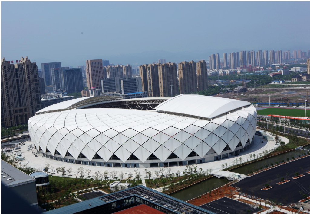
中国轻纺城体育中心体育场位于浙江省绍兴市柯桥区,总建筑面积为77640平方米,拥有4万座观众席位。该体育场屋盖由固定钢结构屋盖、活动钢结构屋盖、承载及机械驱动系统、膜结构围护系统四大部分组成。固定屋盖顶部高度47.107米,活动屋盖顶部标高为57.456米,可开闭钢结构屋盖的开启面积为12350平方米。
