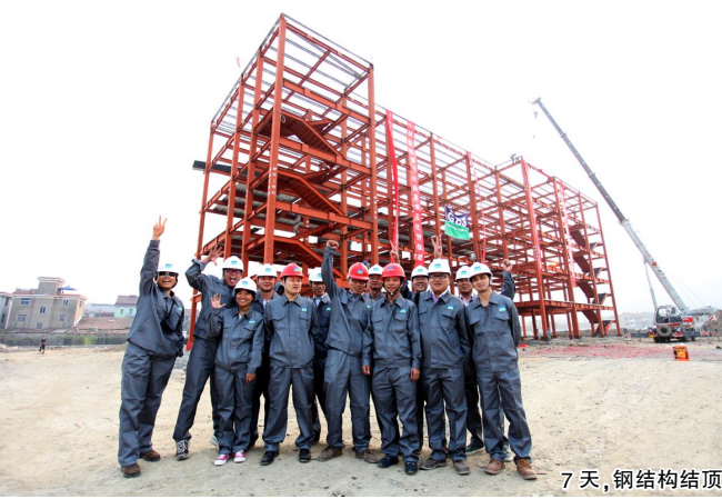
7天，钢结构结顶
